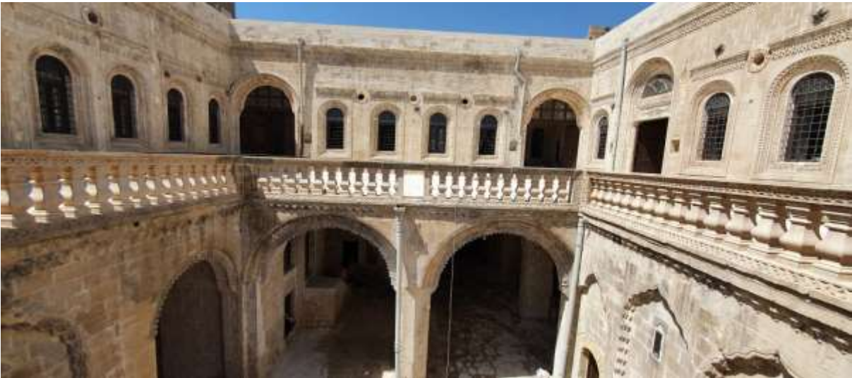
Fotoğraf 92. Gazipaşa İlkokulu (Mükellefi Ailesi evi) Binası (M. Çağlayan)
