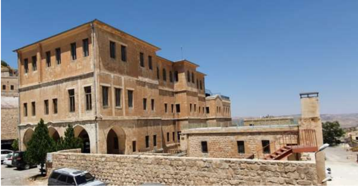
Fotoğraf 88. Eski Hükümet Konağı (MAÜ Mimarlık Fakültesi Binası) (M. Çağlayan)
