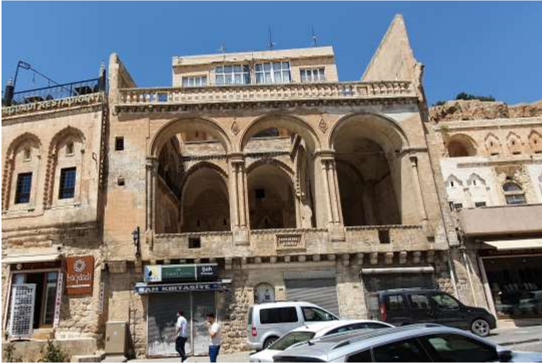
Fotoğraf 93. Şahkulubey Konağı Ön Cephesi (M. Çağlayan).
