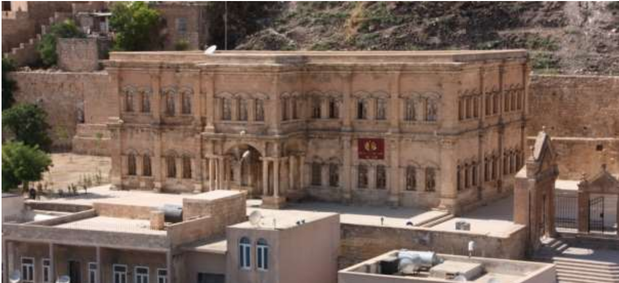
Fotoğraf 87. Mardin Rüştüye (İdadi) Binası (M. Çağlayan)
