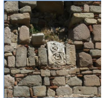
Şekil 23: Bizans sur duvarlarında kullanılan devşirme malzeme.
